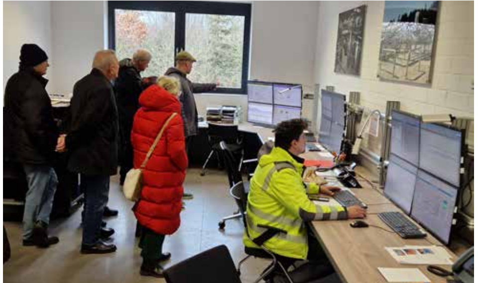
Der Leitstand der Grünwalder Geothermieranlage (3)
