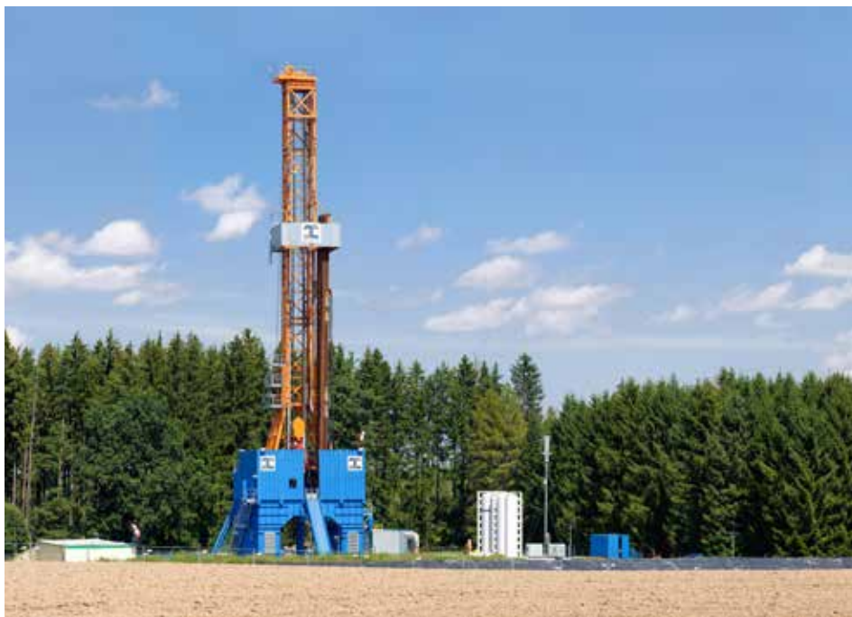
Tiefenbohrung der Grünwald Erdwärme GmbH in Laufzorn, Gemarkung Oberhaching (Pressefoto)
