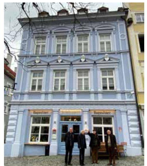
Der Augustiner Brückenwirt am Stadtplatz von Burghausen (2)
